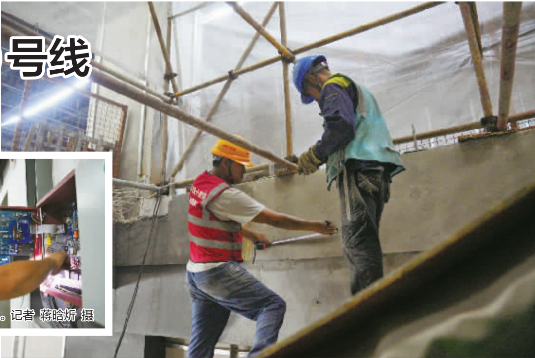
10号线骆兴站,工人正在施工。记者 蒋晗旻 摄
