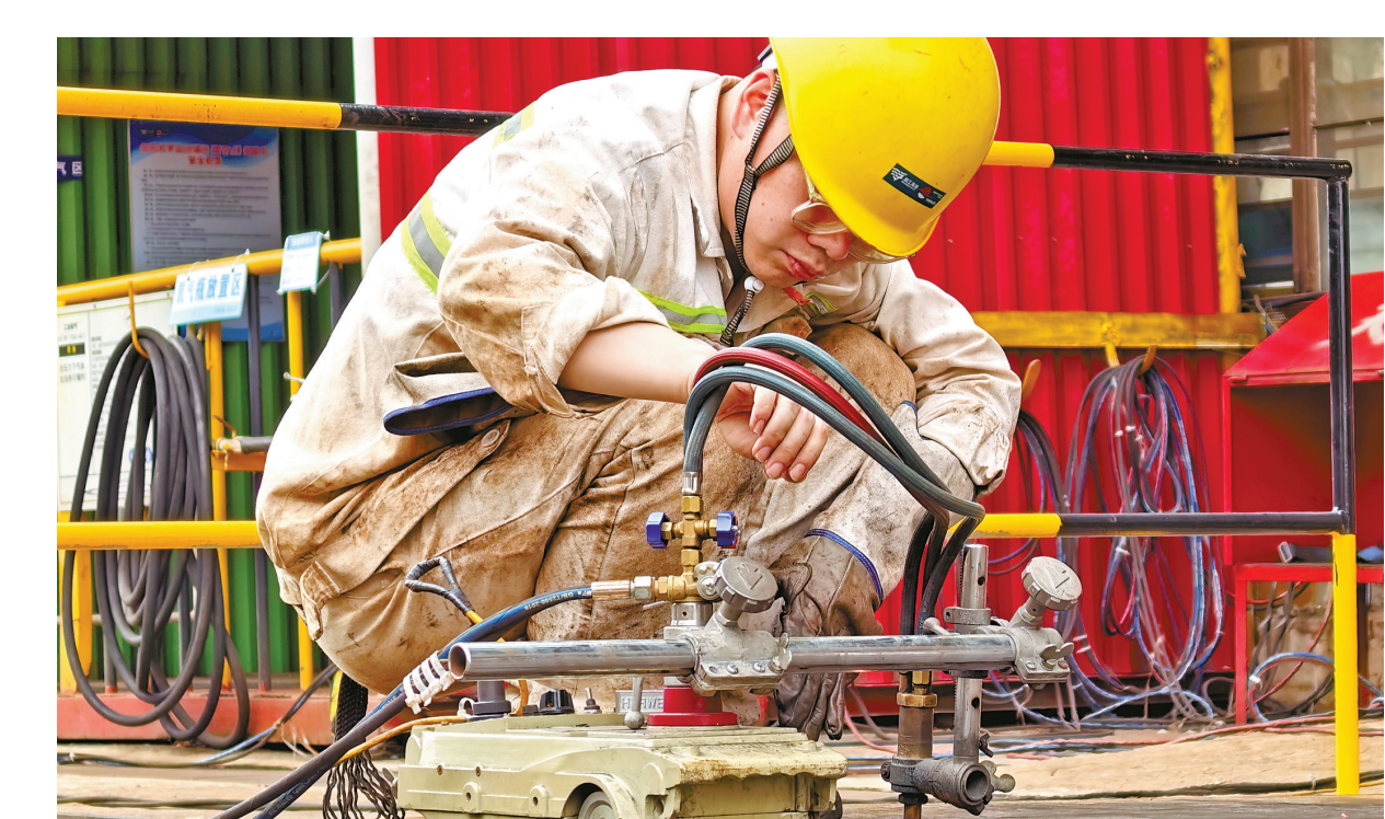
机修工潘琪在机修大院进行钢板切割作业。
