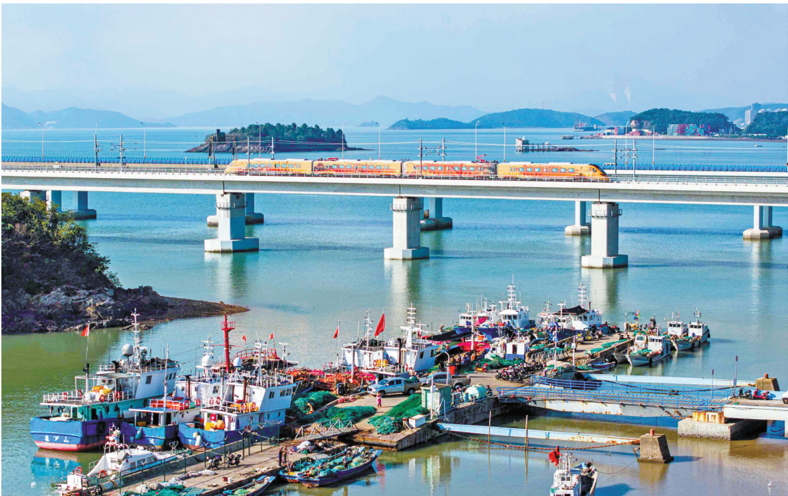
昨天，宁波轨道交通12号线正式开通运营。图为列车驶过象山港跨海大桥。(徐诚 甬轨君 摄)
