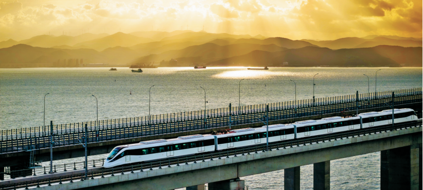
列车通过象山港跨海大桥。（甬轨君供图）
