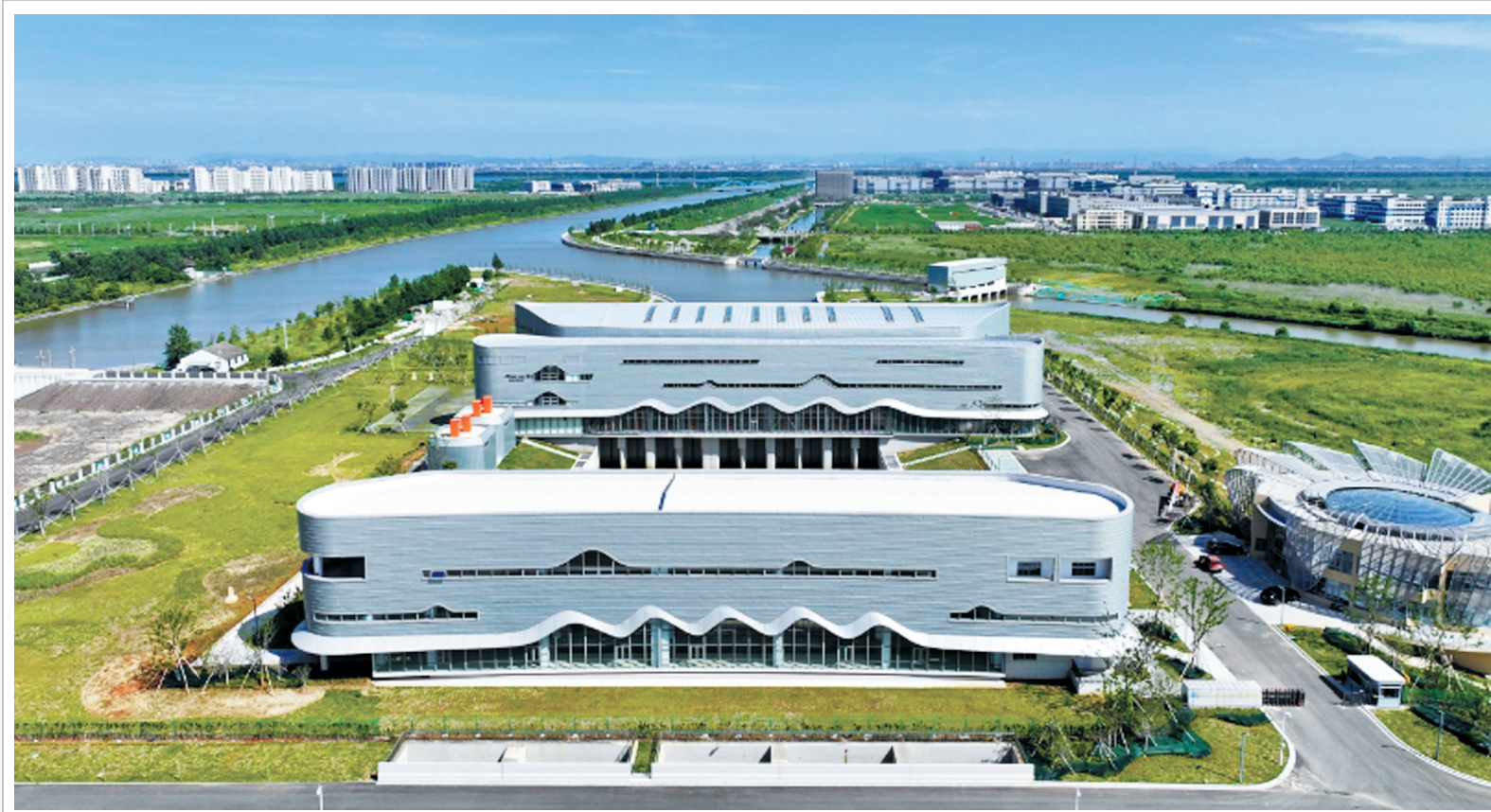
防洪标准达到100年一遇 陶家路江排涝枢纽全面投用
