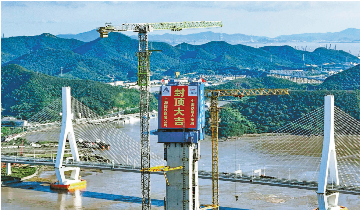
20号主塔浇筑现场。
