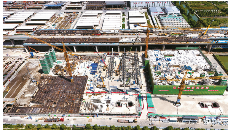
甬甬高铁Ⅶ标慈溪站房项目完成地下结构混凝土浇筑。
