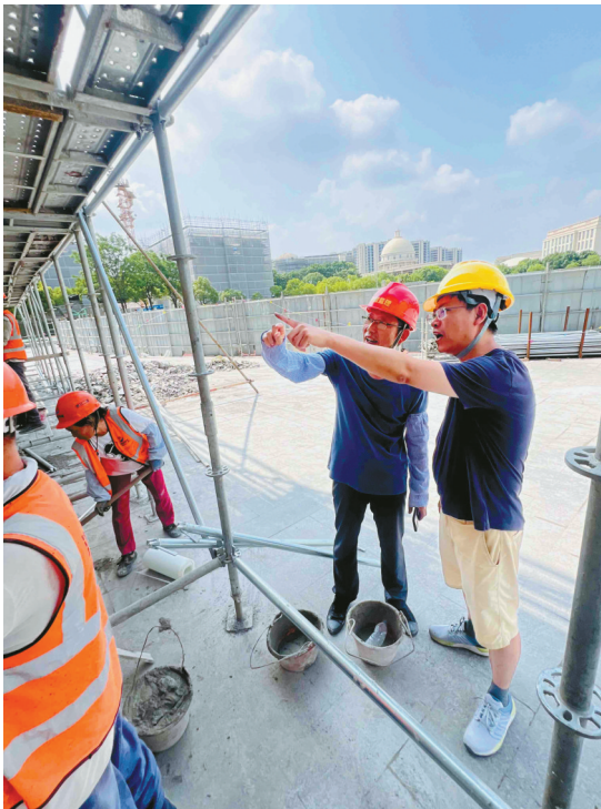
邵琪(右)在施工现场。
