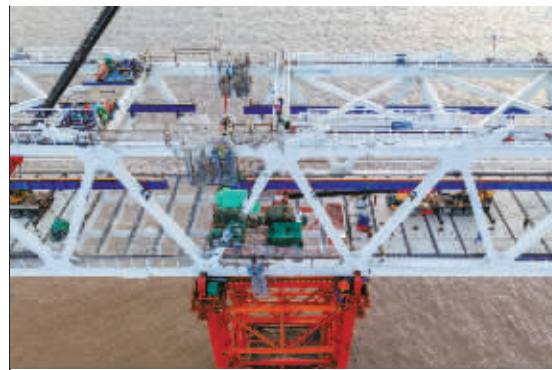
施工现场。通讯员供图
