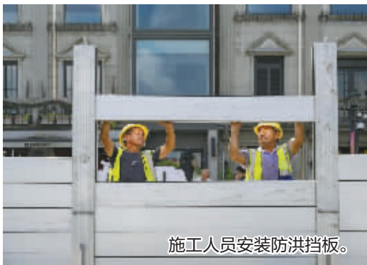
昨日下午,施工人员安装防洪挡板。
