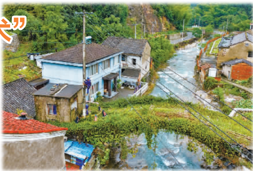
移除古桥旁的电线杆。
