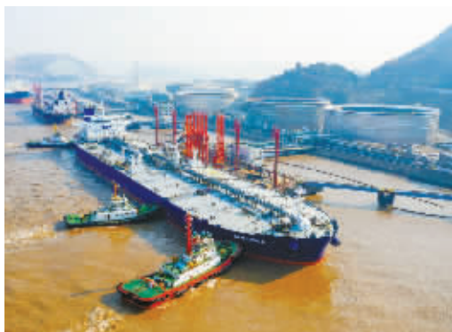
亚洲最大原油码头——宁波舟山港大榭港区实华二期45万吨原油码头。
