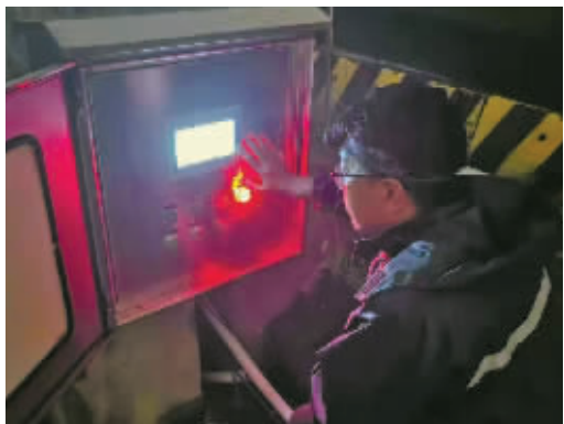
戴阳杰在调流调压阀处进行紧急抢修。
