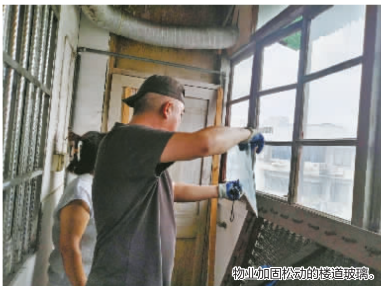
网格员帮居民清理被风吹落的玻璃,排除安全隐患。
