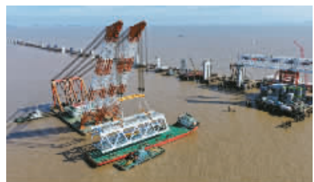
杭州湾跨海铁路大桥南航道桥。
