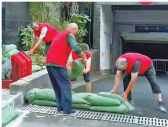
工友配合社区工作人员放置沙袋,预防地下车库进水。
