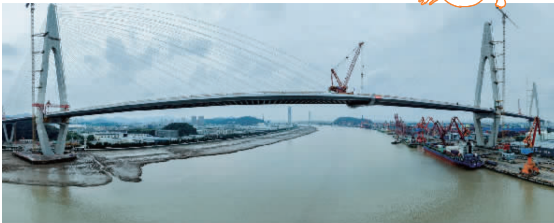
甬江特大桥顺利合龙。通讯员 李全平 摄
