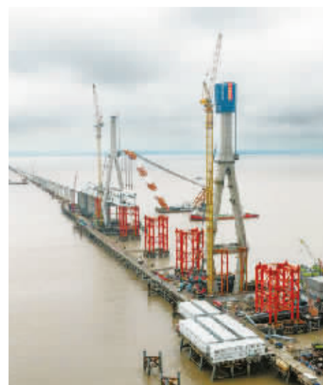
建设中的杭州湾跨海铁路大桥南航道桥。 通讯员供图
