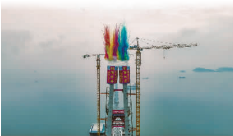
昨天上午,封顶后的礼花在9号主塔绽放。王嘉彬 张顺 摄
