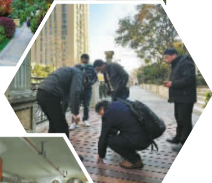
▲“居业物”协同查看防腐木平整情况。
