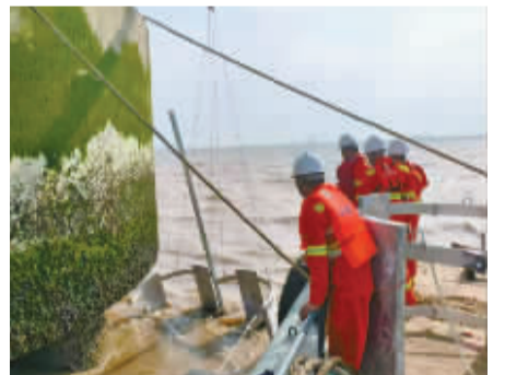
养护人员正在施工。通讯员供图
