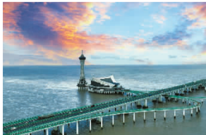
杭州湾跨海大桥“海天一洲”。
