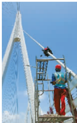
爬索机器人在拉索上进行养护作业。
