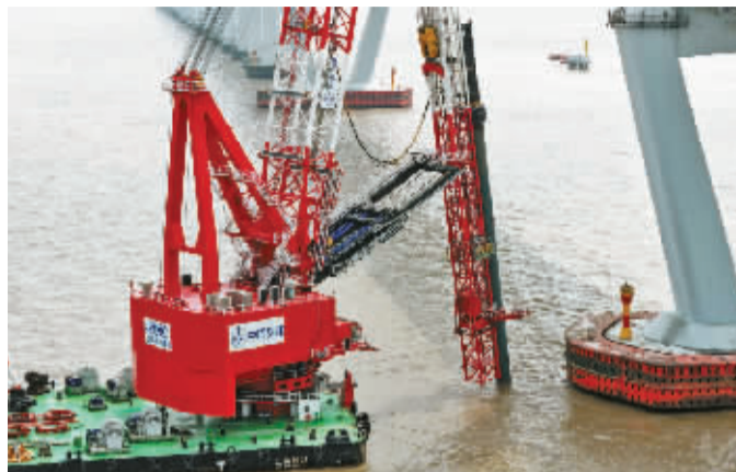
杭州湾跨海大桥B10主墩旁首根钢管桩顺利沉放入海。
