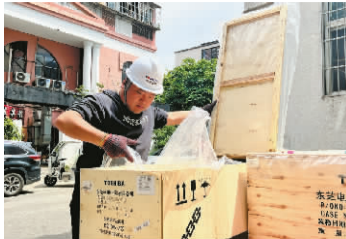
电梯更新工程现场。
