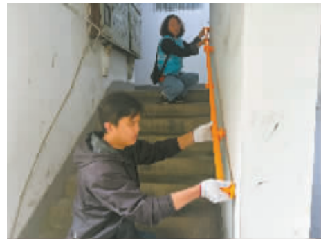
网格员和工人师傅正在安装扶手。
