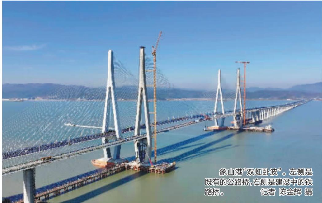
12月29日15:15,随着最后一片钢箱梁精准吊装到位,国内首座市域(郊)铁路跨海大桥——宁波市域铁路象山港跨海大桥顺利合龙。该桥全长8.276公里,是国内紧邻既有桥最大跨径桥梁,也是世界上最大跨径无砟轨道铁路斜拉桥。
