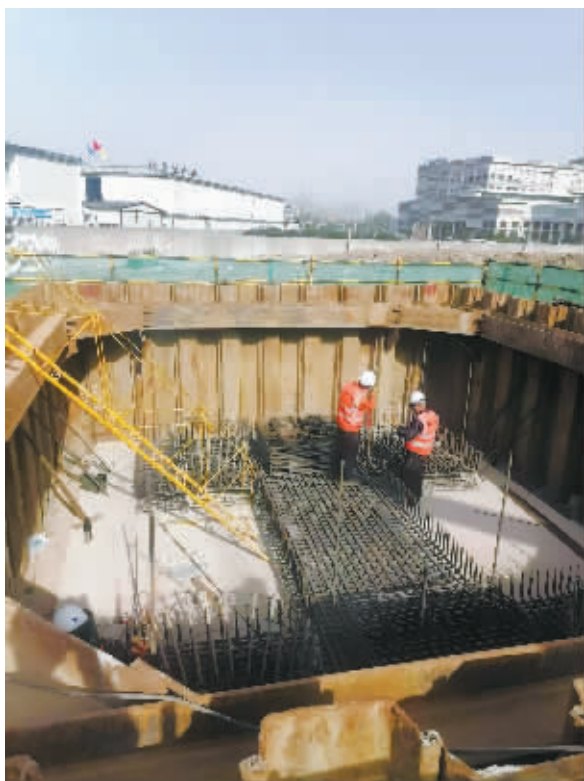
工人正在进行承台钢筋绑扎。
