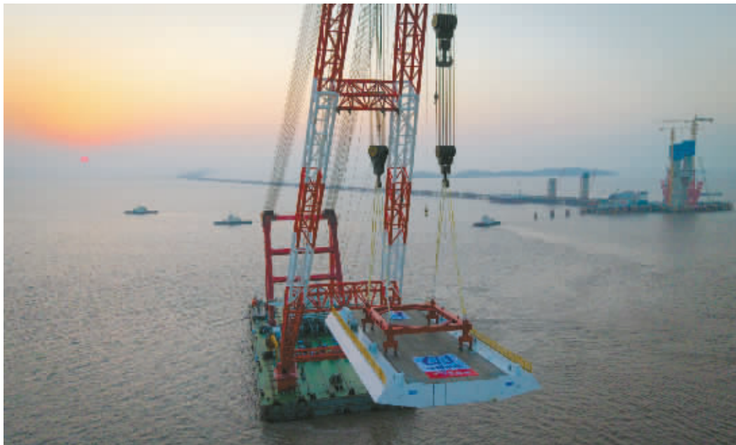
重达626吨的钢梁运送到吊装现场。通讯员供图
