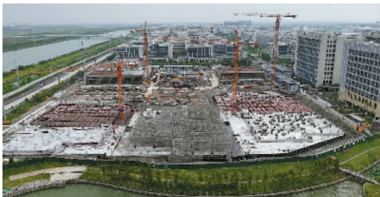
宁波前湾新区空天产业园。
