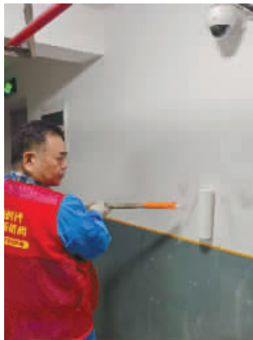
居民正在刷墙。
