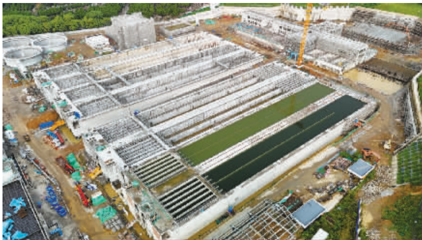
建设中的沉清池。通讯员供图
