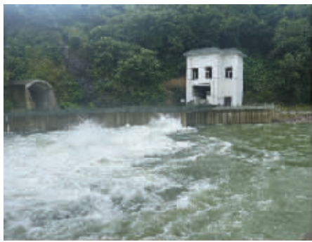
在今年第8号台风“竹节草”来临前，溪下水库开始通过新建泄洪洞预泄。
