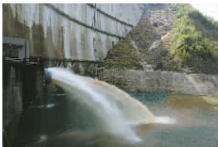
周公宅水库通过改造放空管提升预泄能力40立方米/秒。
