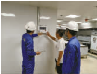
安检员检查学校的燃气报警器。
