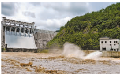
亭下水库正在泄洪。
