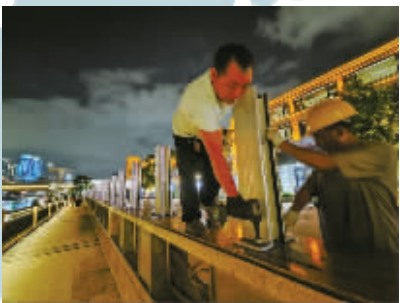
工作人员安装防汛挡板。 记者 施代伟 摄
