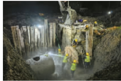
施工人员进行法盲板安装。
