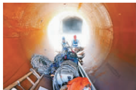
隧道内的建设者。 通讯员供图
