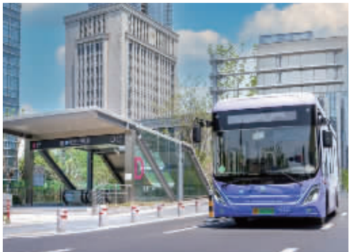
鄞州公园南站D出口。
