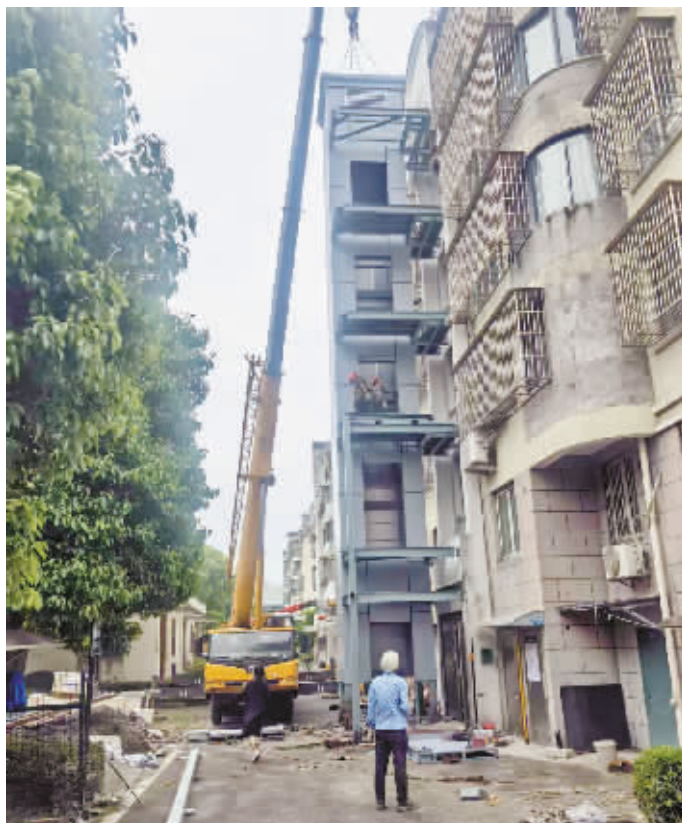
电梯加装现场。
