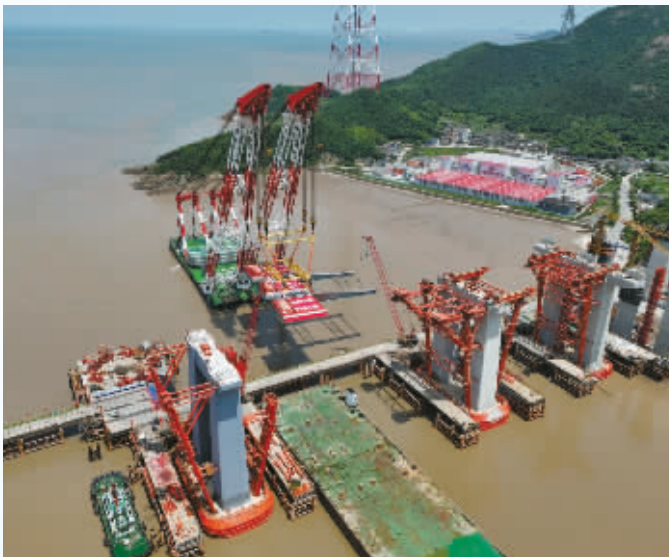
施工中的西堠门公铁两用大桥。通讯员供图
