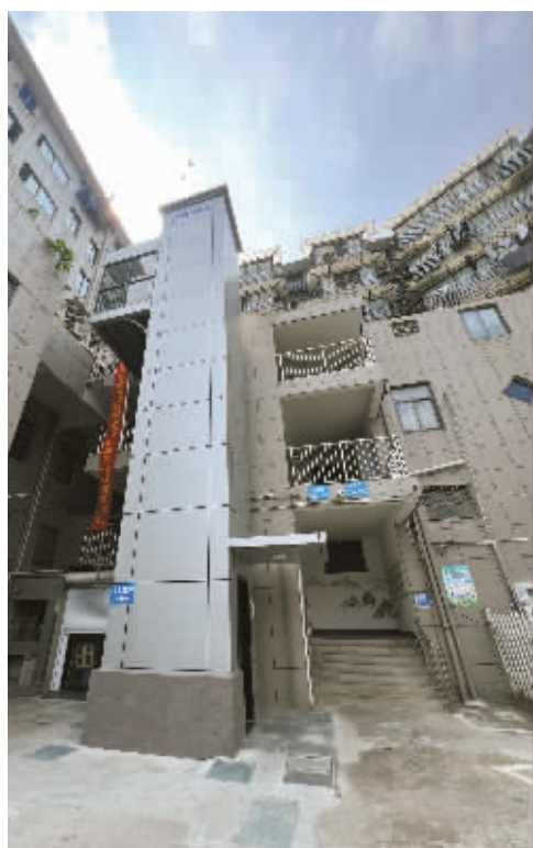
砖桥巷加装电梯。记者 周科娜 摄
