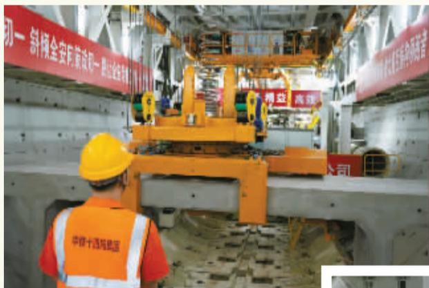
甬舟铁路金塘海底隧道工地,技术人员通过箱涵拼装机吊装盾构箱涵。这是世界最长的海底高铁隧道,将于五月“入海”。 宋新宇 摄
