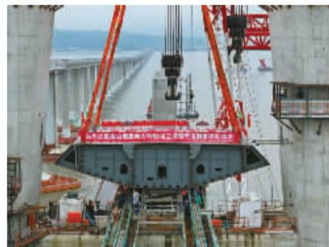
4月27日，象山港跨海大桥主桥段首片钢箱梁就位，借助“北斗定位+智能防抖”技术，近200吨重的钢梁像穿针般被精准对接，海上搭积木，焊缝误差不到一根头发丝粗，毫米级精度铸就“海上天路”。
