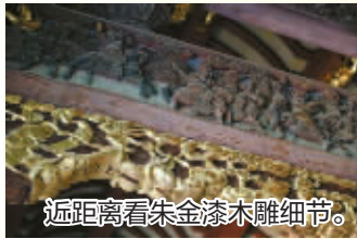
脚手架视角下的梁枋木雕。
