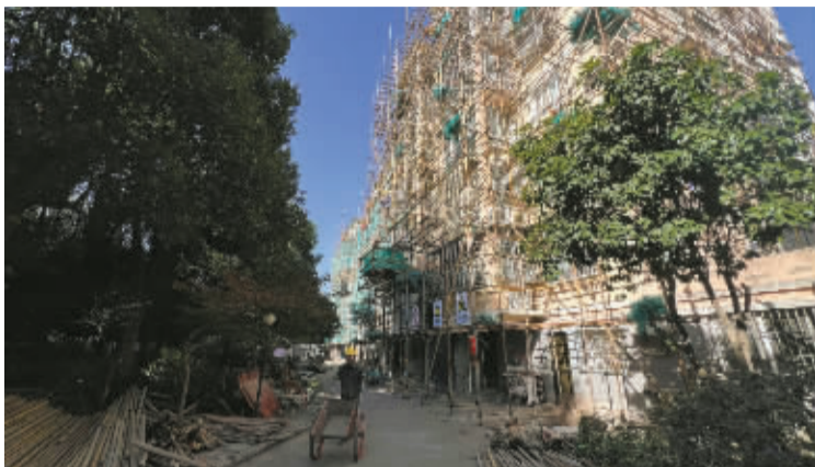
老旧小区改造进行中。
