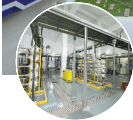
◀渗滤液处理站。
