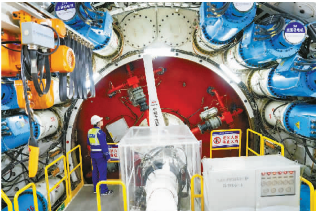
技术人员对盾构机进行检查。
