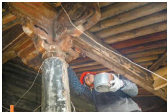
木梁斗拱映斜阳,榫卯参差云水长。 巧匠精心施妙手,重灰抚尽焕荣光。
