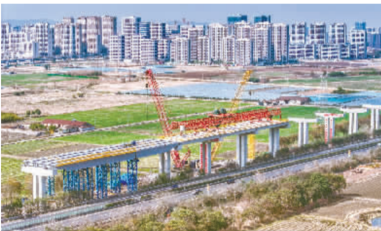
甬台温高速改扩建宁波南段施工现场。
