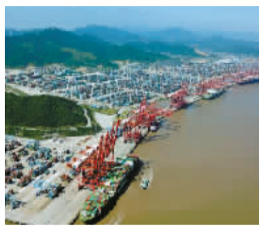
▲宁波舟山港穿山港区集装箱码头。
