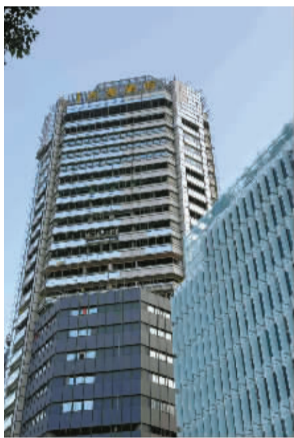
正在进行大楼外立面施工的金港大厦。
